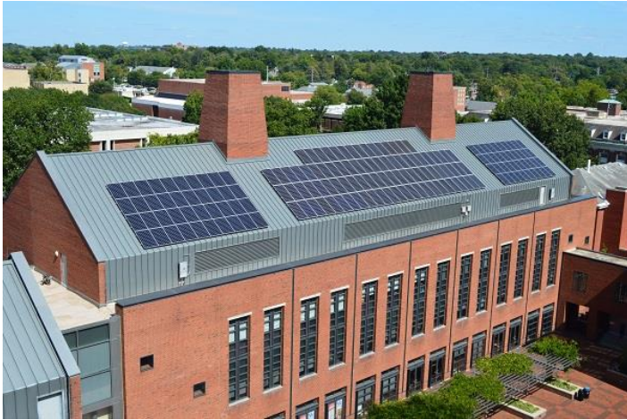
Ralph G. Anderson Solar PV Array
